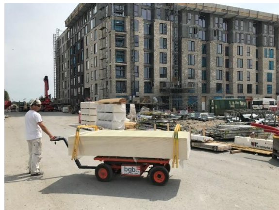
Elektrisk drevet vogn til transport af gipsplader og bygge materialer
